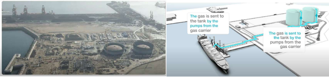
La fase de construcción de la Planta de Regasificación de El Musel (1)
