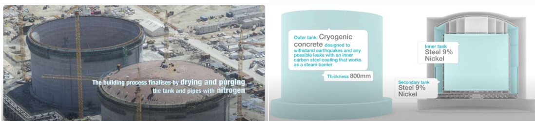
Detalle de los tanques de El Musel y su construcción (1)
